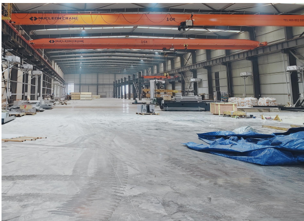
1#车间拟建设备区域
