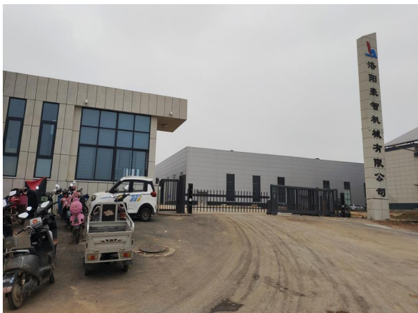
厂区北侧洛阳豪智机械有限公司
