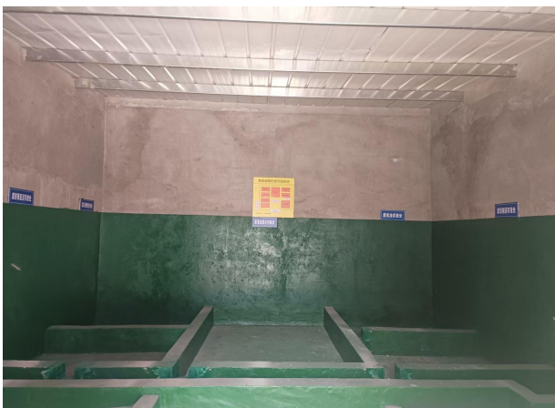
危废暂存间内部
