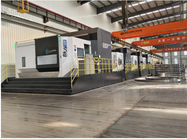
生产车间现状
