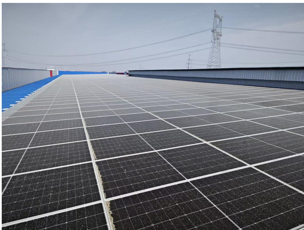
车间顶部安装光伏发电设备
