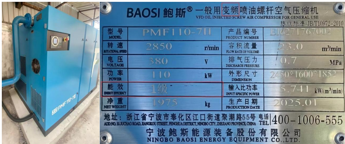
图2 公司主要通用用能设备采用变频 I 级能效设备
