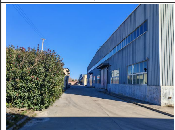
厂区车间东侧
