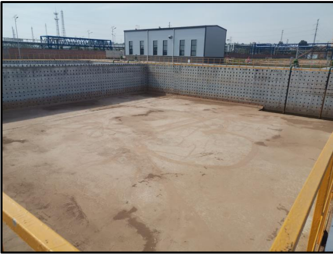
厂区事故水池
