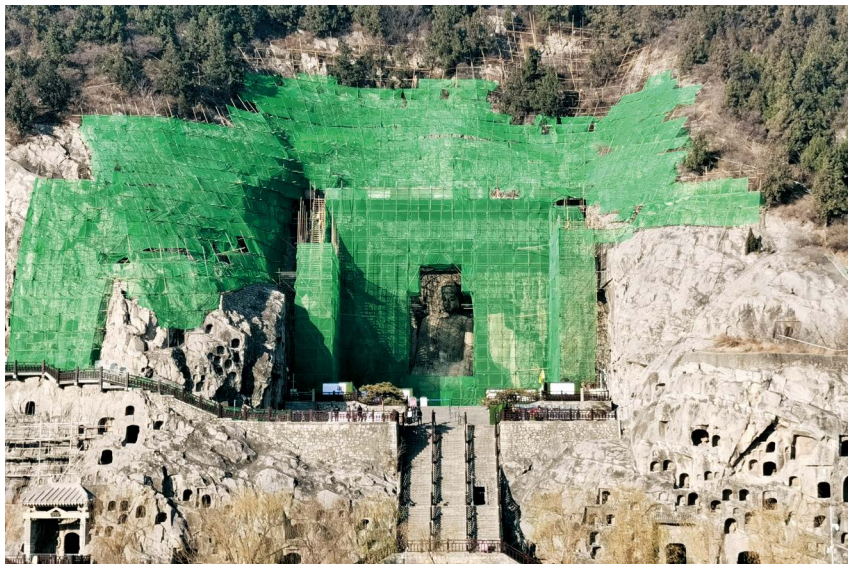
● 2022年，奉先寺保护工程施工现场 龙门石窟研究院提供
