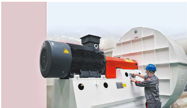
◎ 2022年5月，洛阳北玻三元流风机技术有限公司制造、检测风机类产品
