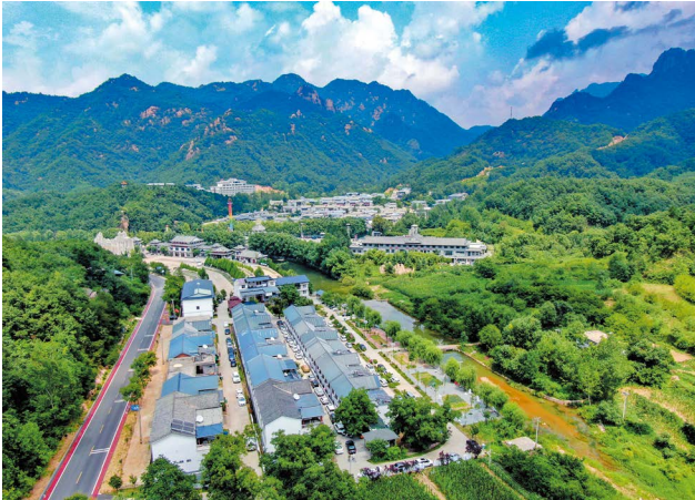
◎截至2022年8月5日，嵩县车村镇在14个村新建、改建民宿50余家。图为车村镇黄水村民宿
