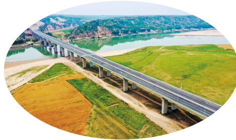
◎ 2022年5月26日，国家重点工程国道207线河南孟州至偃师黄河公路大桥及连接线工程通车
