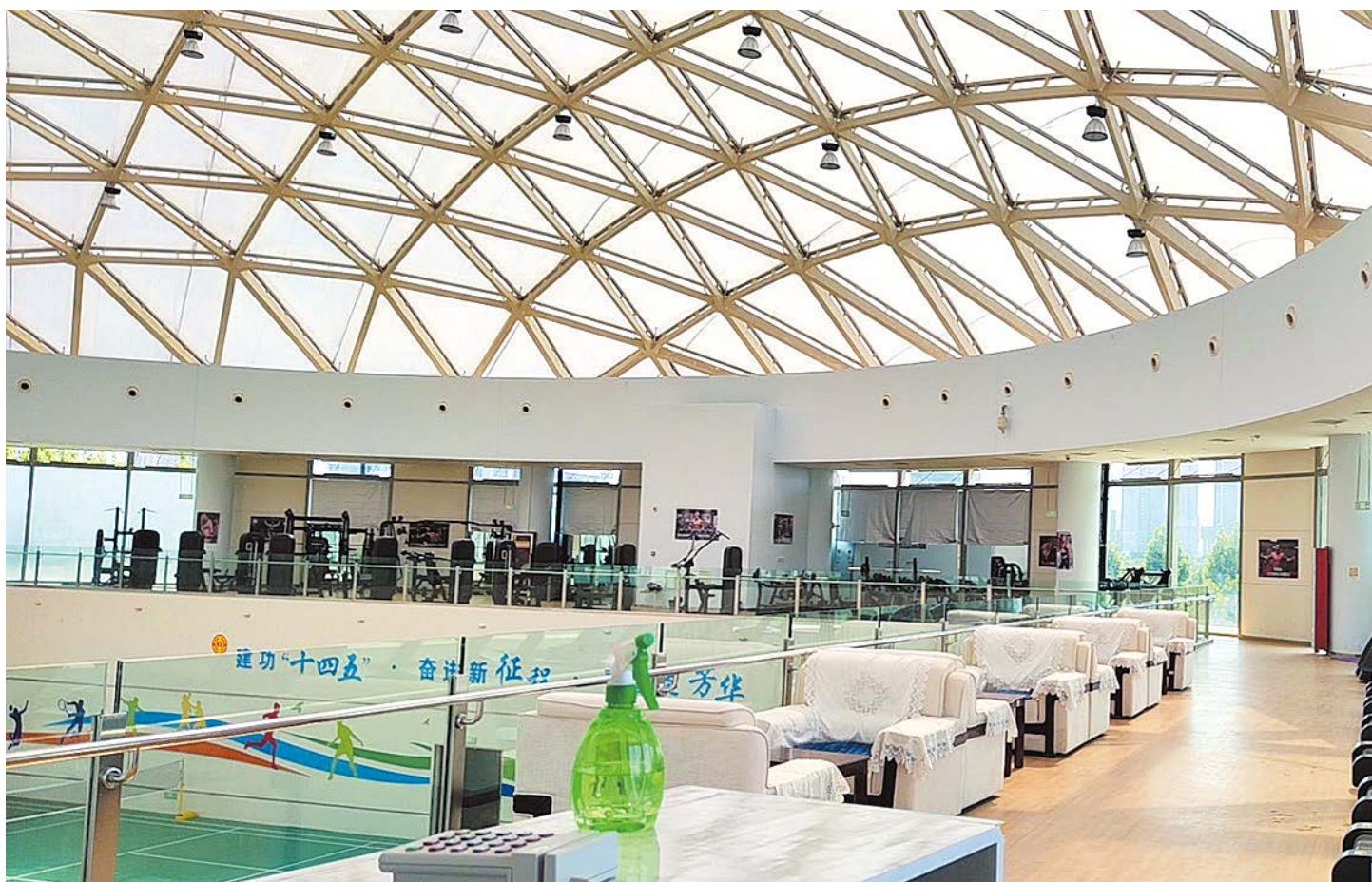
◎ 2022年6月14日，全市首个青年职工俱乐部——洛阳大数据产业园俱乐部建成投用
