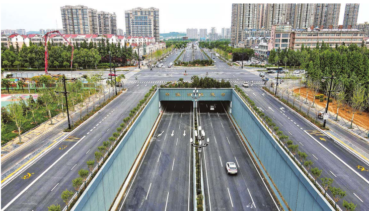
◎ 2022年5月，周山大道下穿开元大道瀛洲隧道通车
