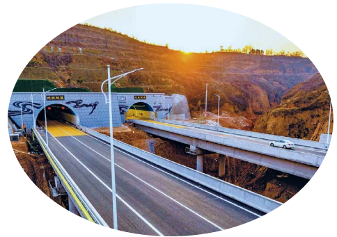
◎ 2022年12月26日，滠浙高速公路洛宁段建成通车。图为光武隧道
