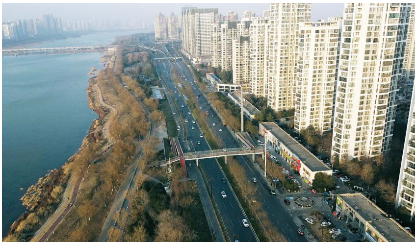
● 2022 年 9 月，滨河南路拓宽改造完成 市住建局提供
