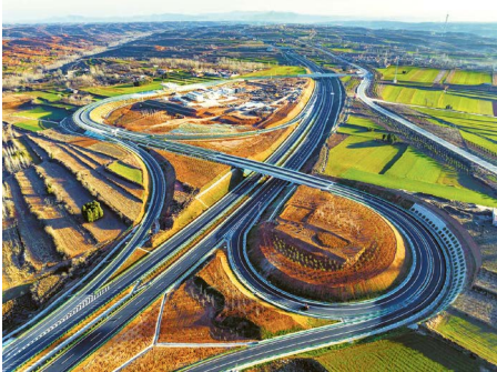
◎ 2022年12月26日，新伊高速建成通车。图为盐镇站互通立交
