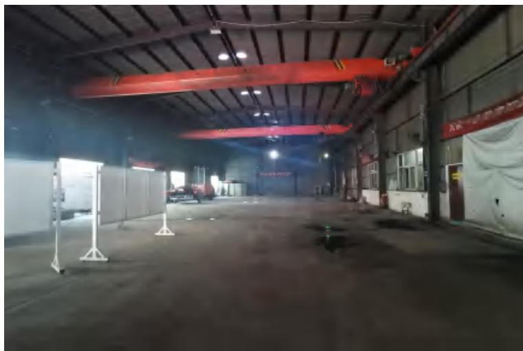
生产车间内部现状
