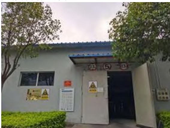
危废暂存间外
