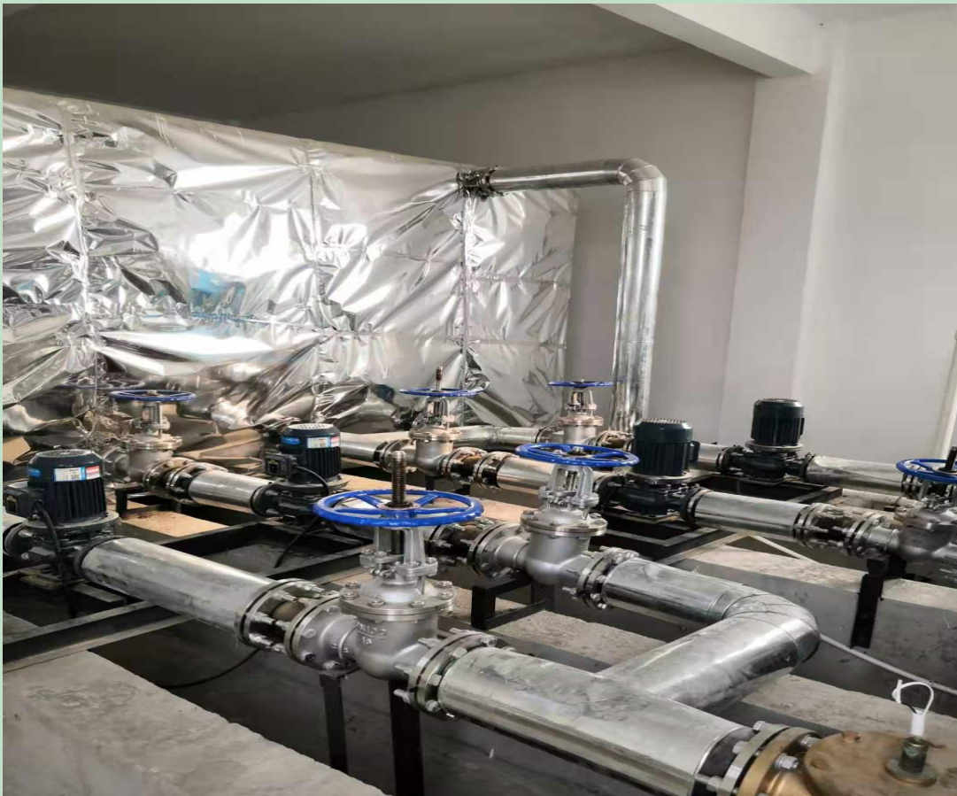
现场图片-二层蓄水池及混水装置
