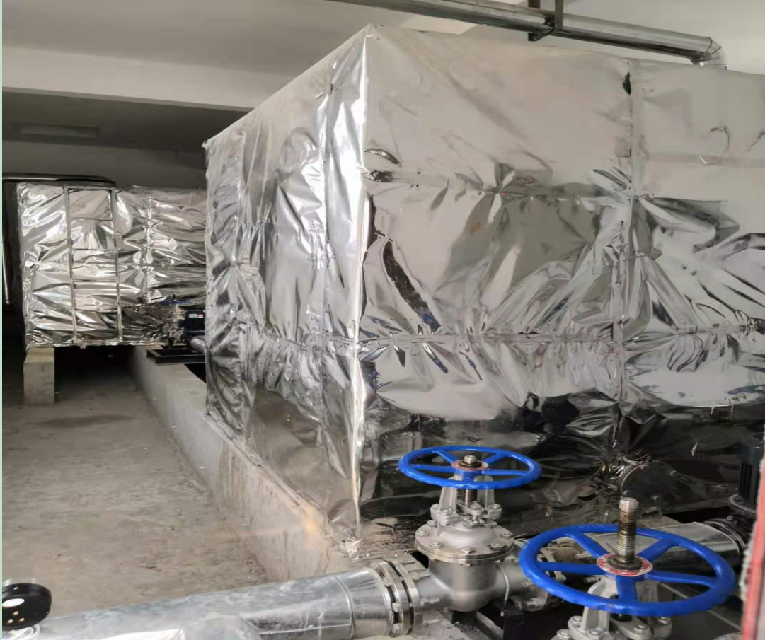
现场图片-二层蓄水池及混水装置
